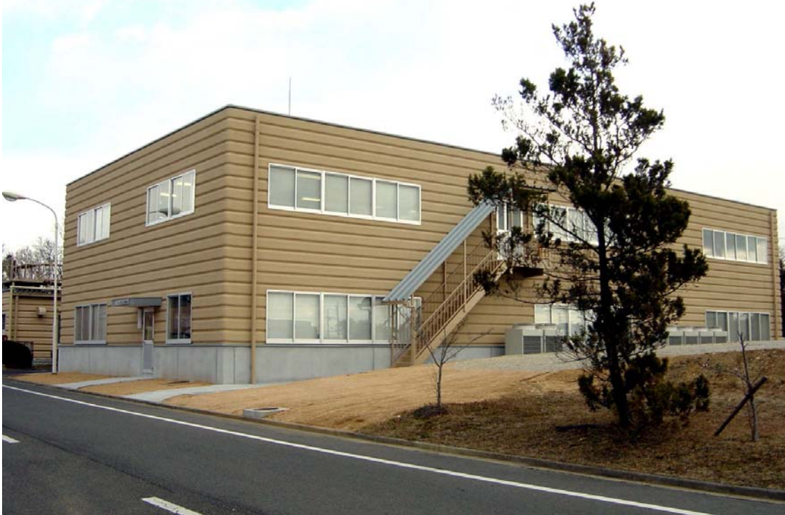
Foto 2: Vista exterior del Centro de Pruebas equipado con 4 tanques de agua
